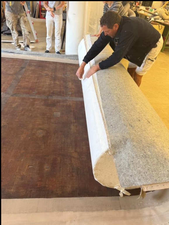
IMBALLAGGIO con VELINE PROTETTIVE della pellicola pittorica e ARROTOLAMENTO su tubo in polistirolo
