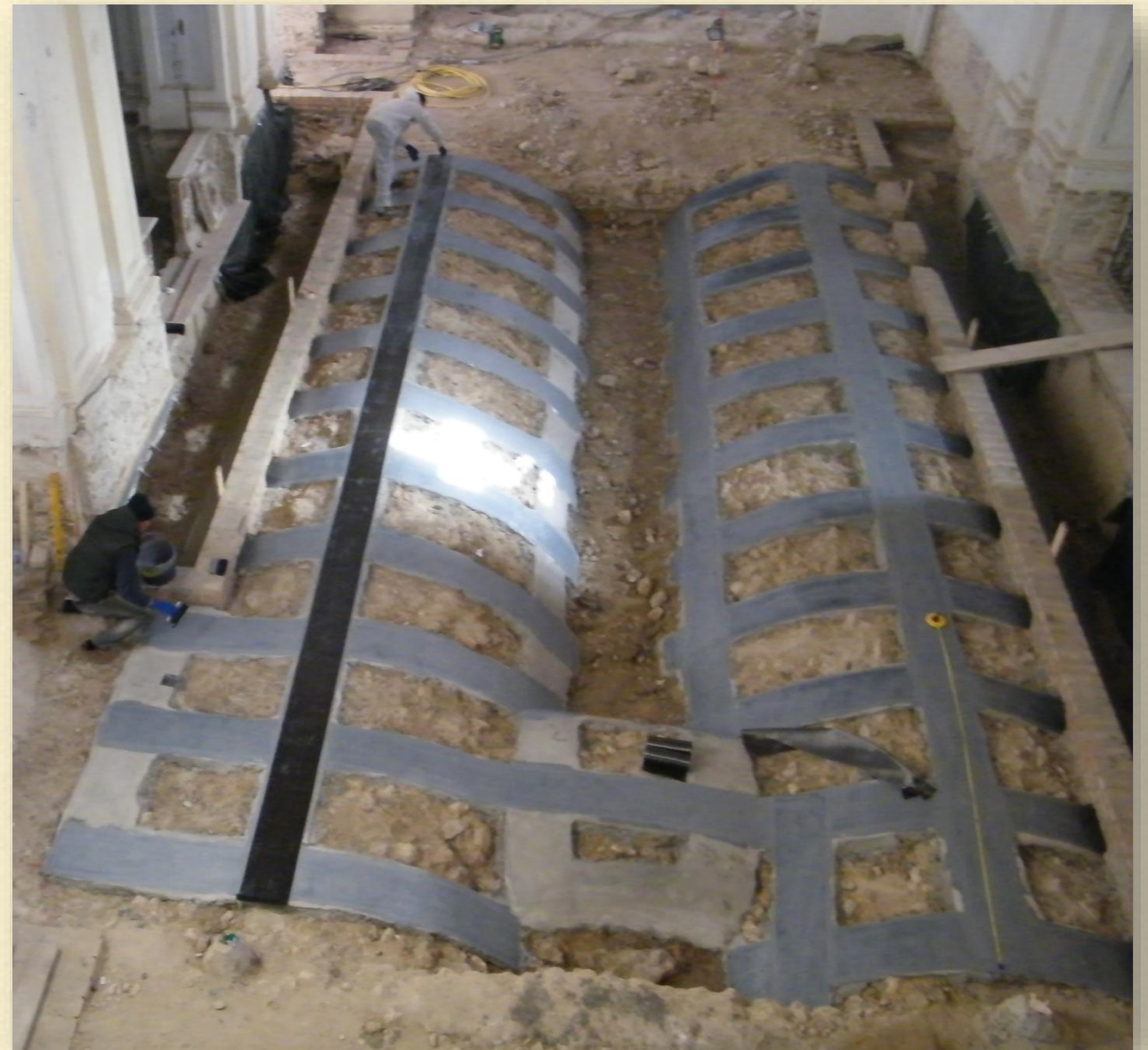
Consolidamento in fibra di carbonio - volte
